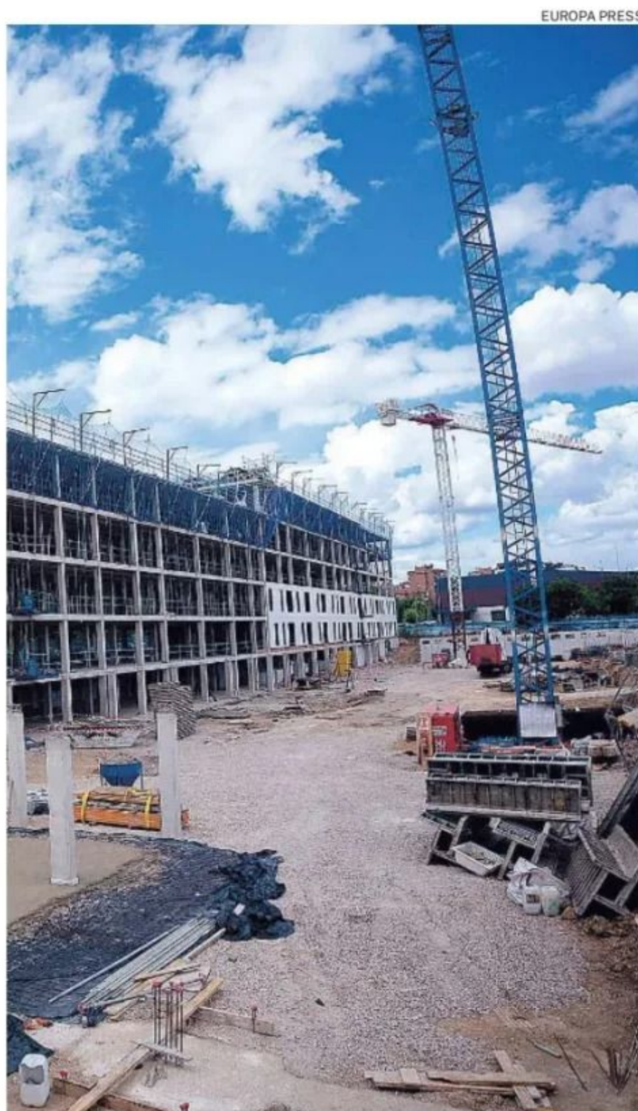
Obras en bloques de viviendas en Madrid
